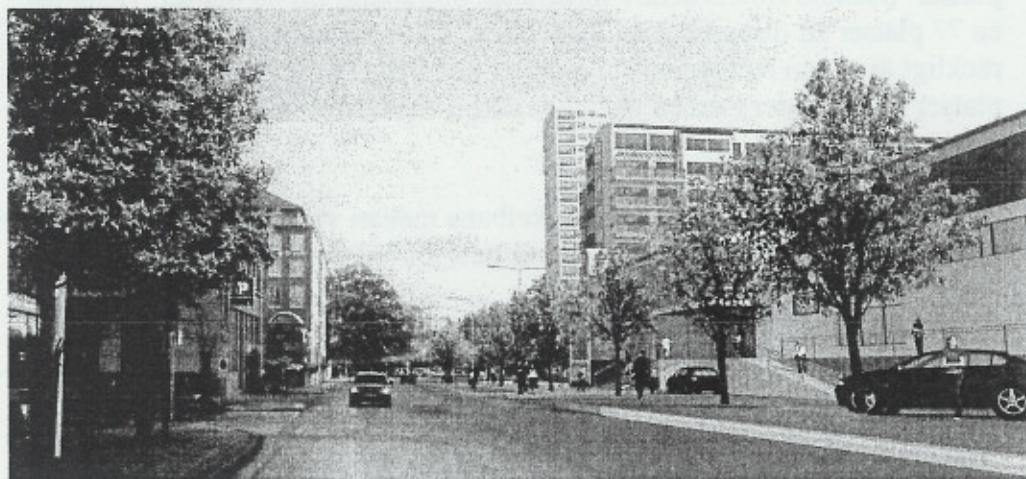
Gustavslundsvägen med tennishallen, den påbyggda gymbyggnaden och det nya bostadshuset på höger sida. I bakgrunden syns planerat högt hus på grannfastigheten Racketen 11.
