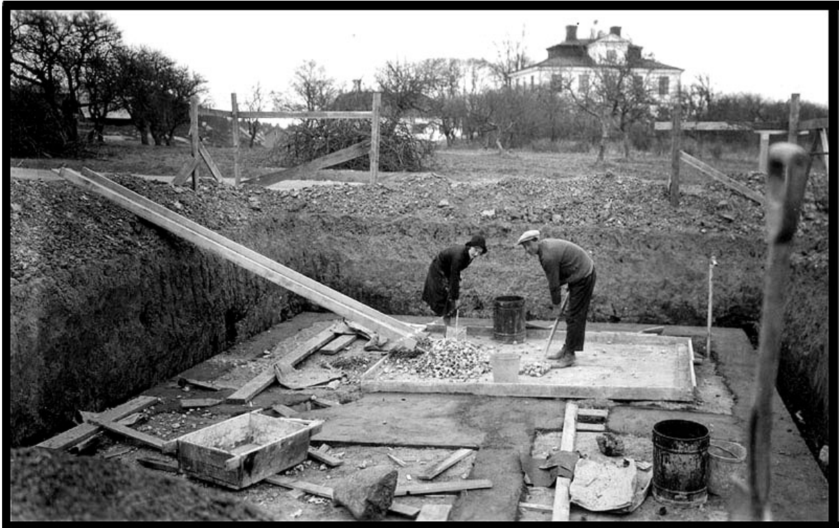
Gjutning av grundplatta till hus i Norra Ängby småstugeområde. Stockholm stadsmuseum.
